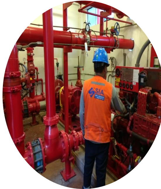
Instalación y Mantenimiento de Sistemas Contra Incendio
