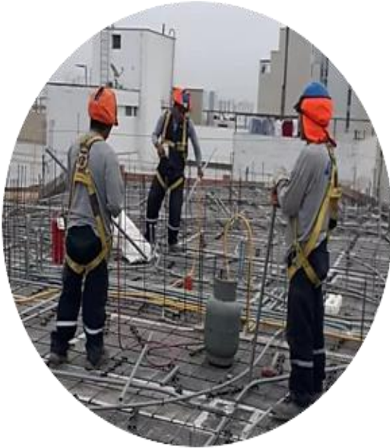
Instalación y Mantenimiento de Sistemas Eléctricos
